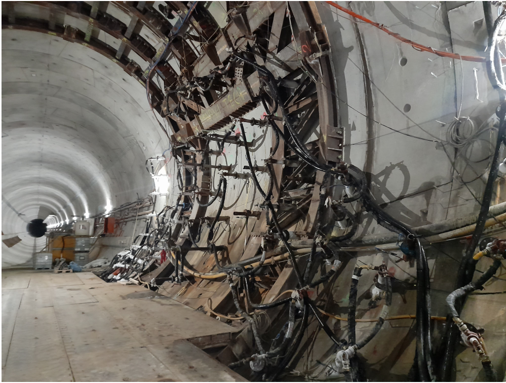
Na zdjęciach przygotowania do mrożenia gruntu poza obudową tunelu
