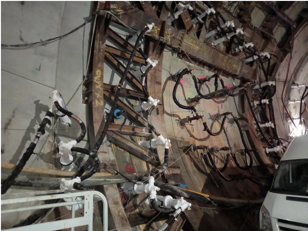
Na zdjęciu przygotowania do mrożenia gruntu poza obudową tunelu
