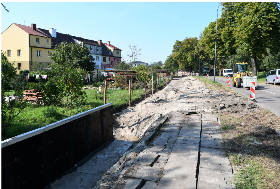
Na zdjęciu powyżej i trzech poniżej ostatni odcinek inwestycji.
