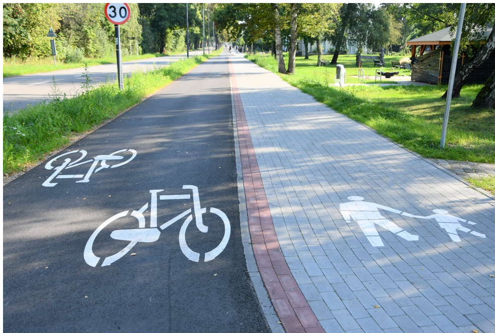
Na zdjęciu fragment już gotowej drogi dla rowerów i chodnika.
