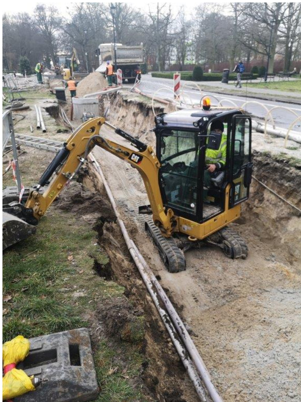
Zdjęcie z prowadzonych prac.
