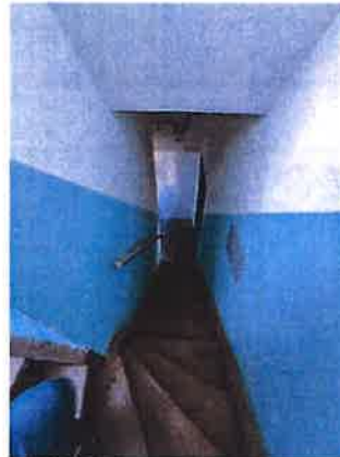
POMIESZCZENIE NR 0.1 dolna część biegu schodowego
