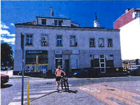
WIDOK NA BUDYNEK OD STR. ul. B. CHROBREGO
