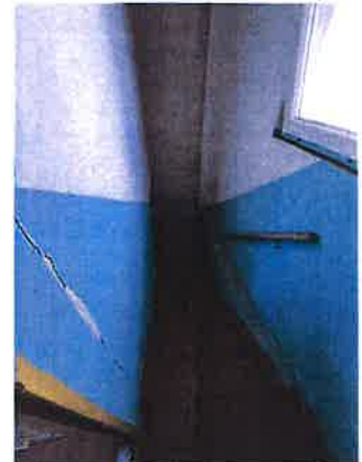
POMIESZCZENIE NR 0.1 górną część biegu schodowego
